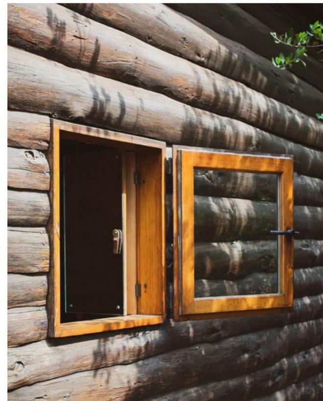
l'une des deux fenêtres carrées équipée d'un vitrage extérieur et d'un volet pliable intérieur
