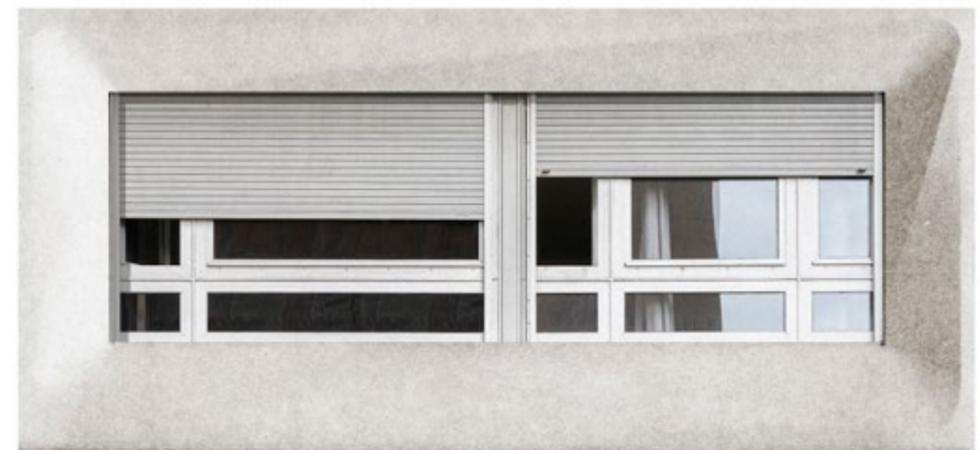
restitution d'un panneau de béton préfabriqué type avec sa baie menuisée, tour Sapporo
